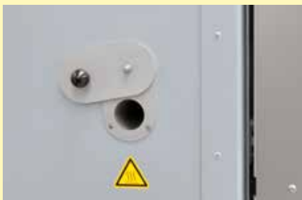
Термоэлементный ввод
